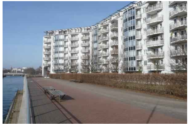
Terrasse am Berlin-Spandauer-Schiffahrtskanal
