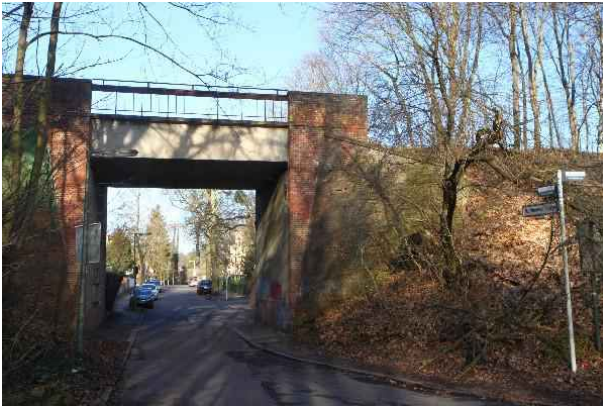
Bahnbrücke Machnower Straße
