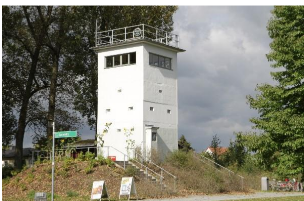
Grenzturm Nieder Neuendorf
