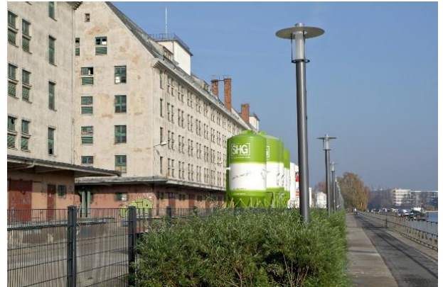
Speicher an der Havel
