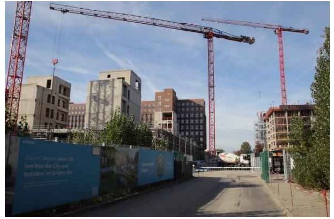
Baustelle Siemensstadt Square
