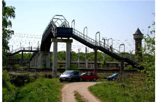
Fußgängerbrücke Bhf. Elstal
