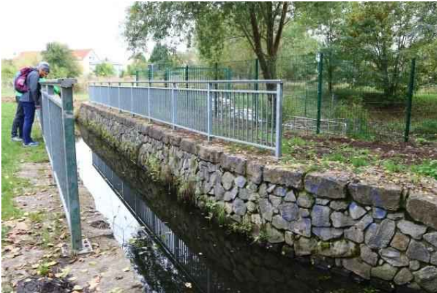
Alte Wuhle - Brückenbauwerk
