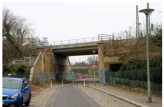
Bahnbrücke Grünalter Straße
