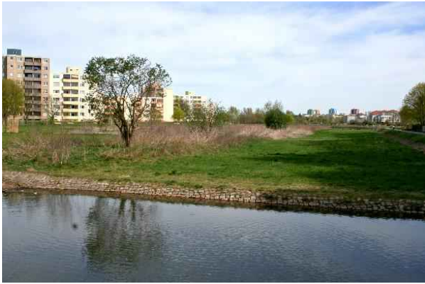
Regenwasserbecken am Nennhauser Damm
